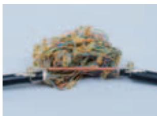
После подготовки сростка и восстановления экрана на кабель накладывается мастика
